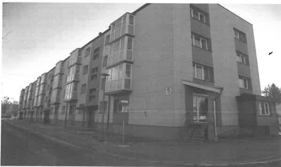
V. Kudirkos g. Nr. 5, Naujoji Akmenė namas apšiltintas ventiliuojamomis fasado plokštėmis.
