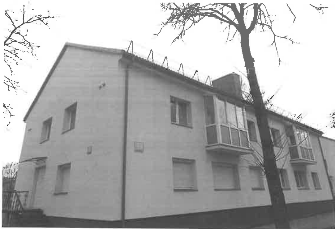
Žalgirio g. Nr. 5, Naujoji Akmenė namas apšiltintas polistirolo plokštėmis aptinkuojant.
