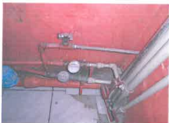
Prieš vamzdynų remontą
